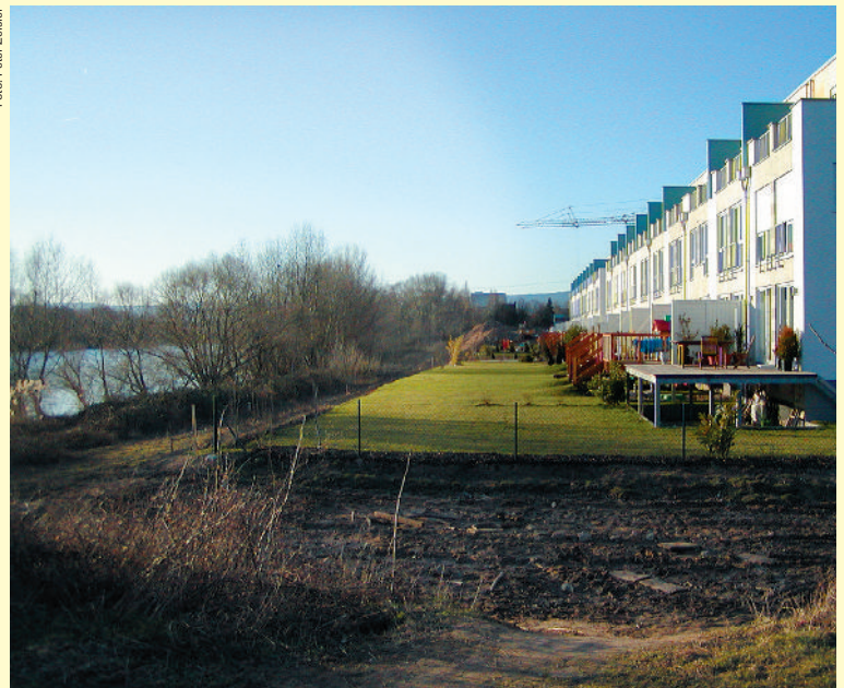
Hochwasserangepasste Bauweise mit erhöhtem Erdgeschoss
