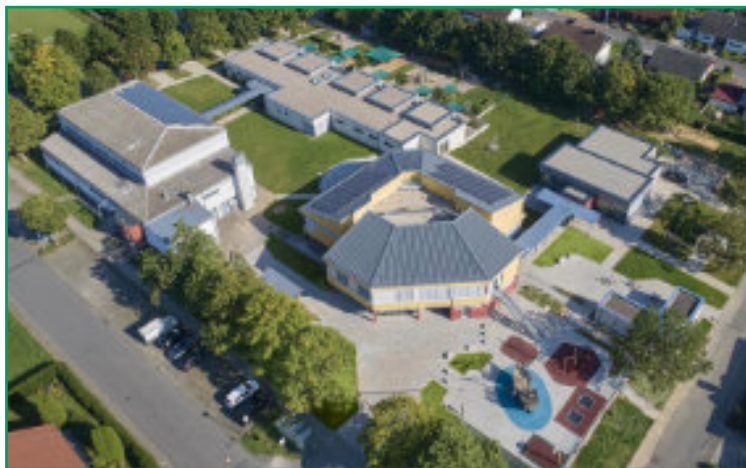
Welzbach-Grundschule in Werbach
